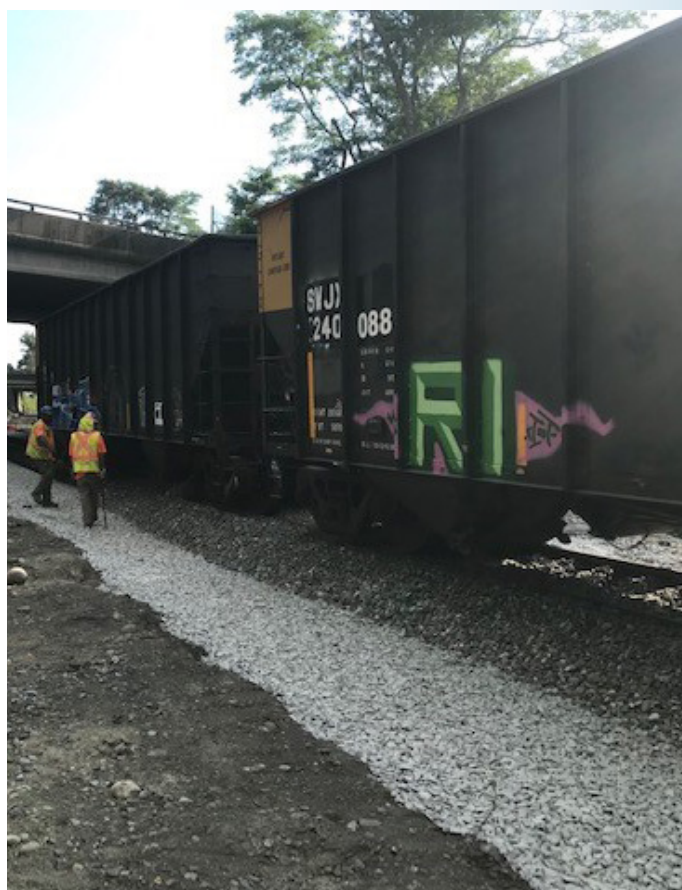
Fornecimento de balastro por comboio na Route 79 Bridge
