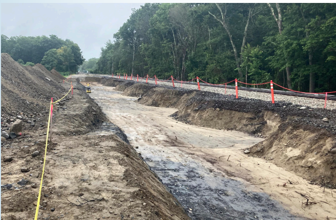
Preparação do local da Freetown Station
