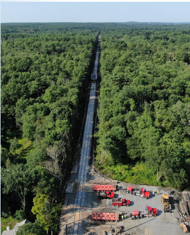
Montagem da Ponte do Rio Assonet no local de instalação final
